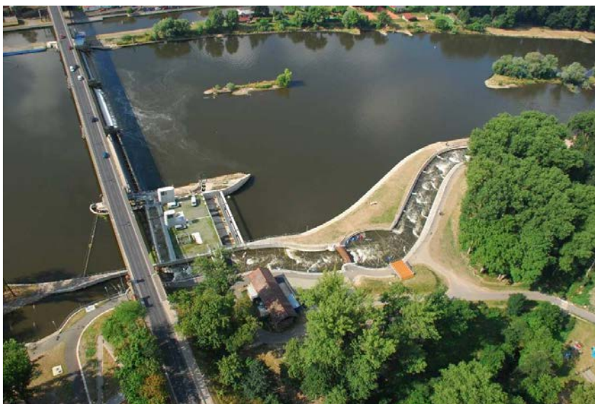
Obrázek: konstrukce USD v prostoru staré vorové propusti na toku (USD Roudnice nad Labem dostupné na
