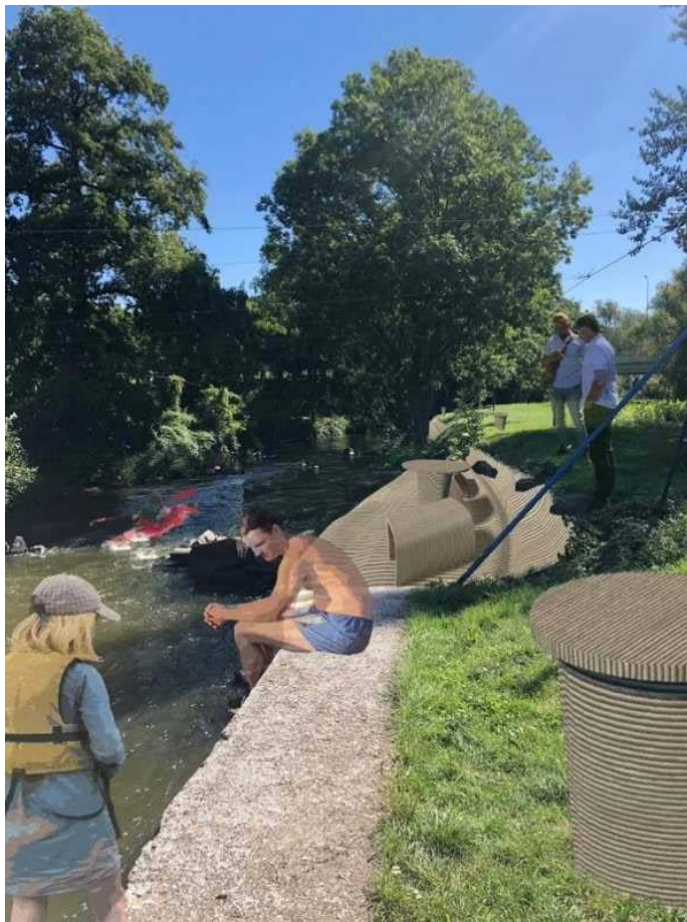
Obrázek: vizualizační návrh břehů z 3D tištěného betonu (Pollert, Umělá slalomová dráha Kadaň 2020)
